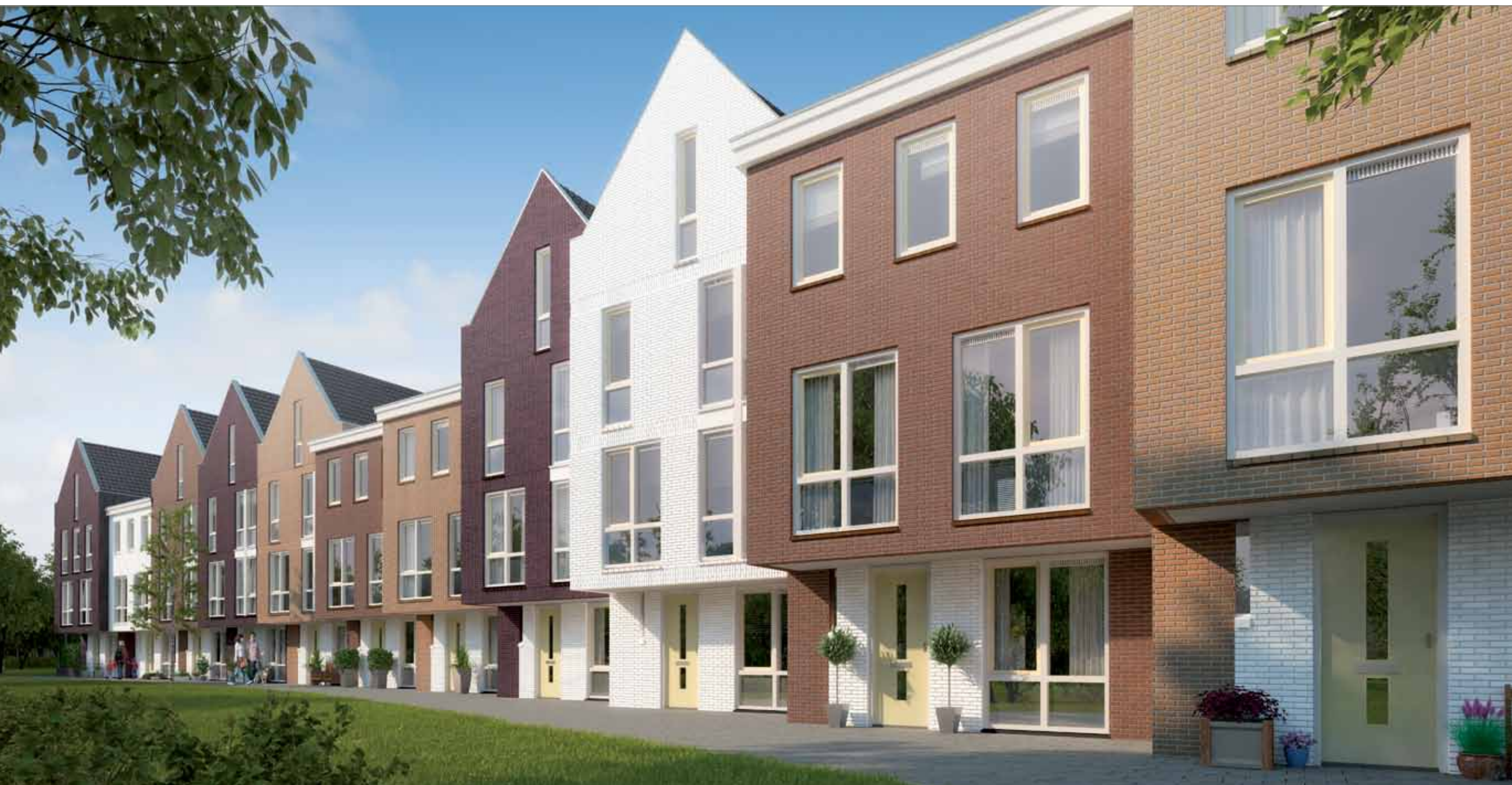
De hoekwoningen zijn standaard 3-laags, met een platte dakconstructie. De hierboven afgebeelde kap is optioneel.
